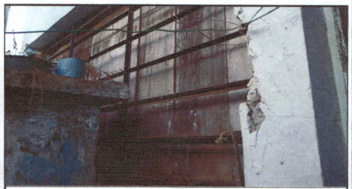
Foto 6: Cambio de Ventanas por deterioro
