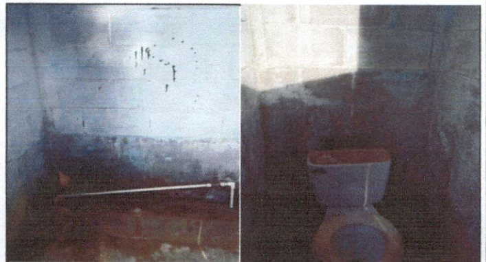
Foto 4: Cambio de baños por mal estado
